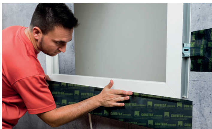
Sellado interior con CONTEGA SOLIDO IQ
