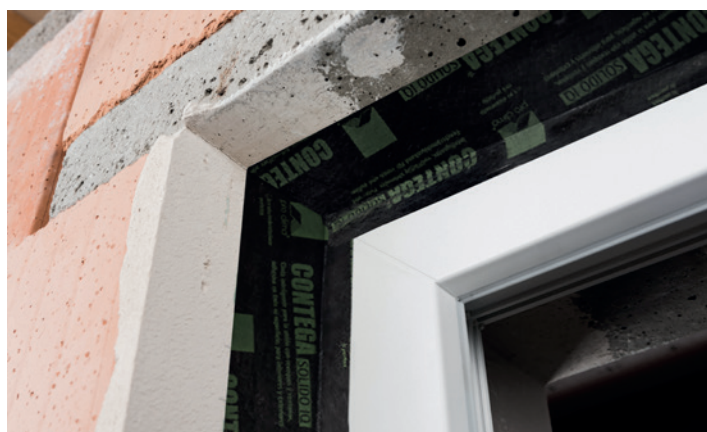
Sellado exterior con CONTEGA SOLIDO IQ
