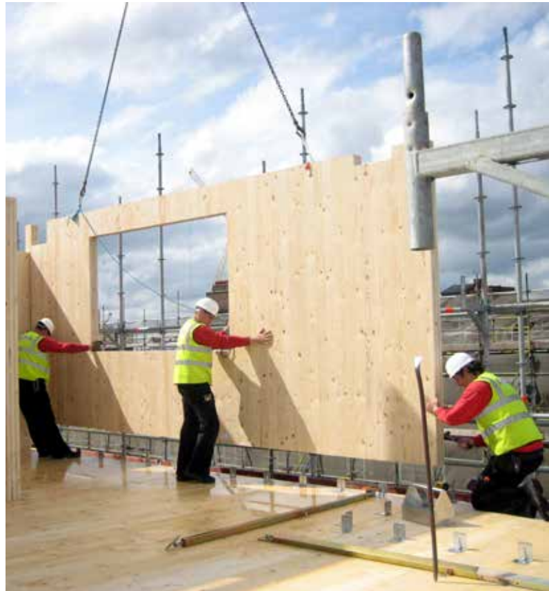
Stadthaus, Murray Grove. Imagen suministrada por KLH UK.
