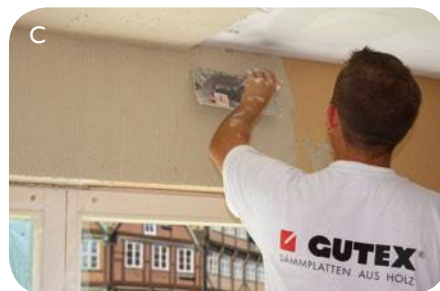
C Aplicar el revoque de acabado interior
