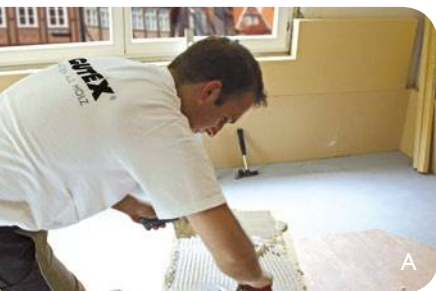
A Aplicar el mortero adhesivo GUTEX Klebe- und Spachtelputz
