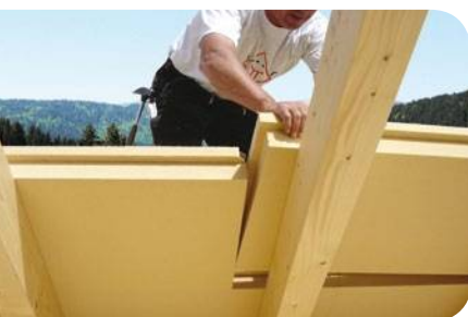
Colocación directamente por encima del cabio
