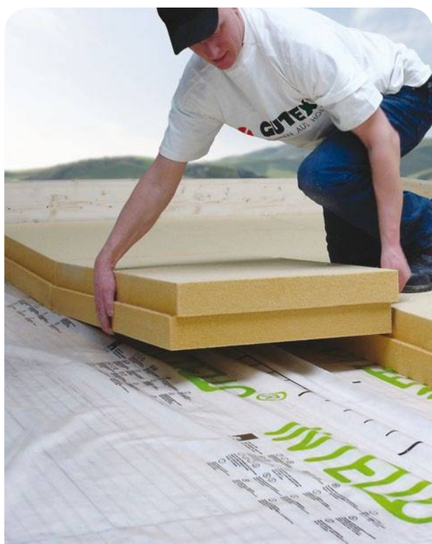
GUTEX Thermoflat® encima de un soporte de hormigón
