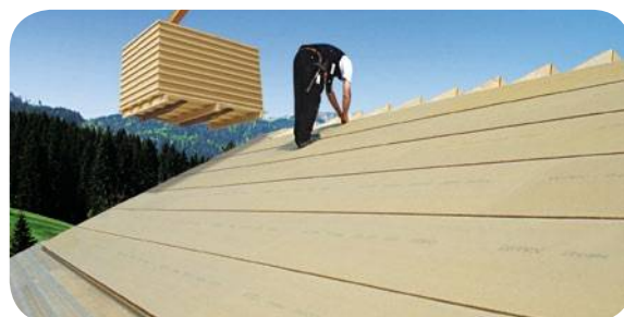
Bajo-teja como cubierta provisional hasta 12 semanas frente a la intemperie
