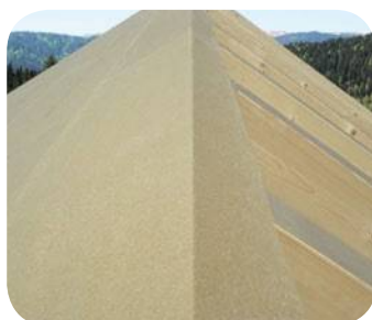
Ajuste libre de fisuras en la cumbreira
