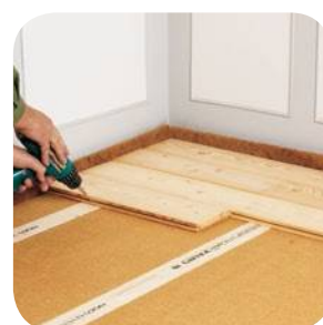
GUTEX Thermosafe-nf ® con rastrel de colocación incorporado y tarima maciza
