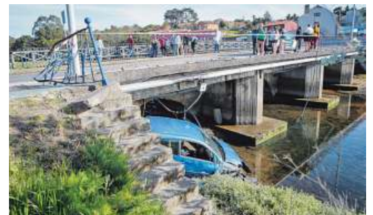
El vehículo acabó sobre uno de los soportes del viaducto. M. CREO
