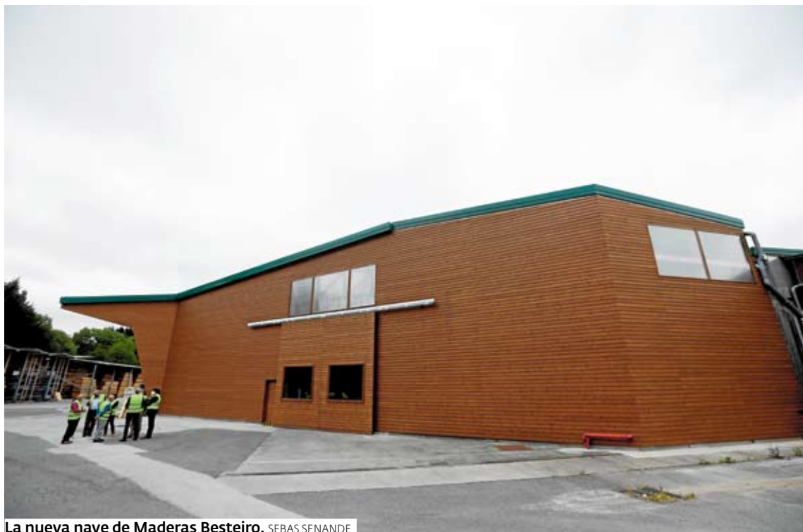
La nueva nave de Maderas Besteiro. SEBAS SENANDE
