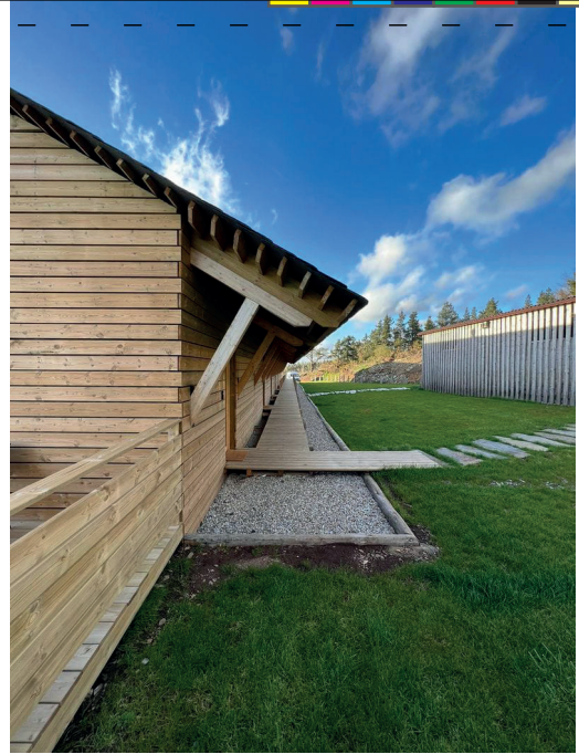
De establo a vivienda Olladas de Barbeitos.
