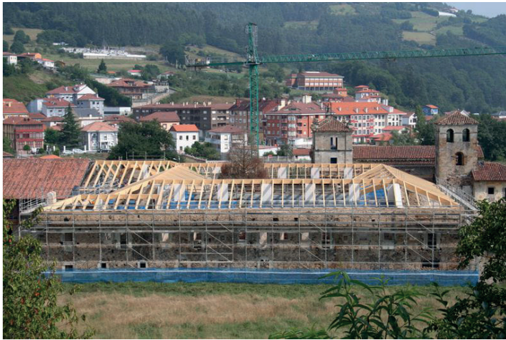
Rehabilitación de la cubierta Monasterio de Cornellana.
