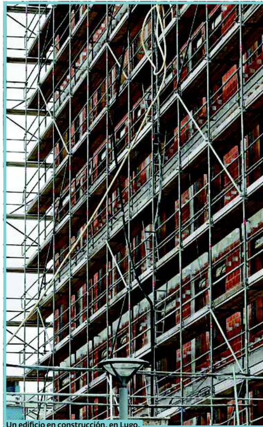
Un edificio en construcción, en Lugo.
