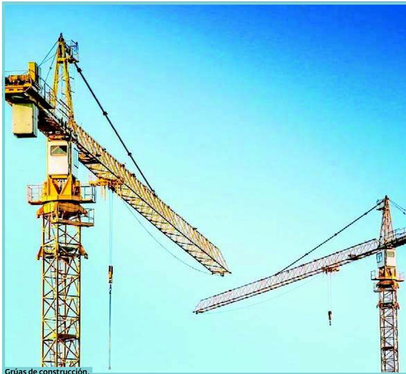
Grúas de construcción.
