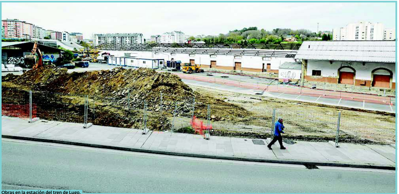
Obras en la estación del tren de Lugo.
