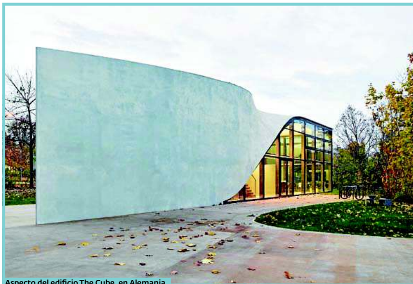
Aspecto del edificio The Cube, en Alemania.
