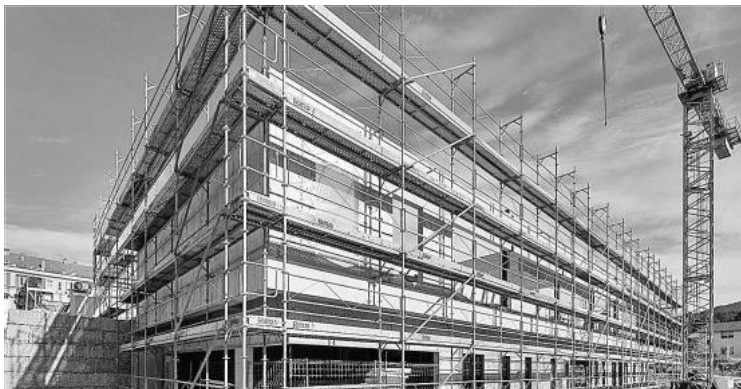
La estructura interior de madera, durante la construcción de las plantas superiores. | Copasa
