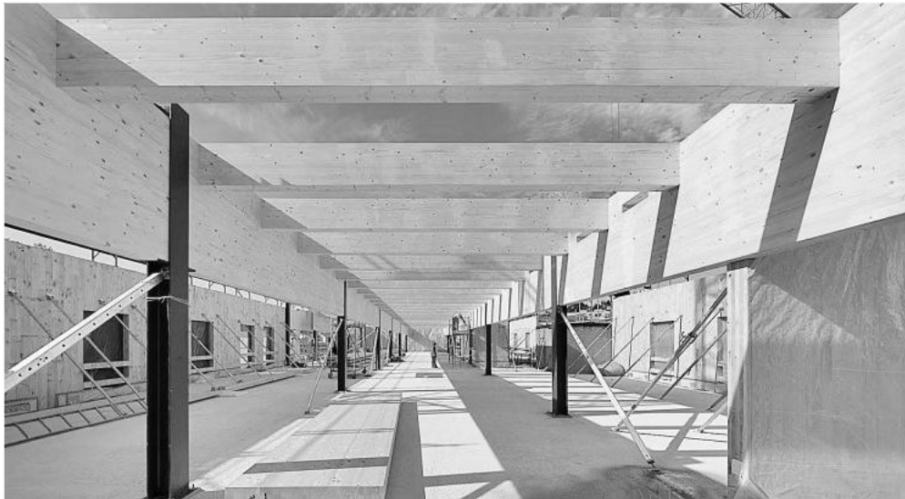
Trabajo de instalación de vigas y suelos, en los primeros meses de la obra en los terrenos de Sisalde. | Copasa
